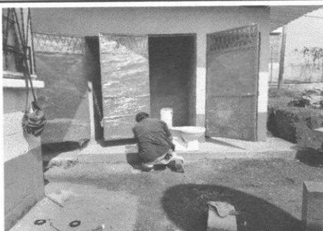
Foto 9: Sustrucción de losa sanitaria módulo 4
