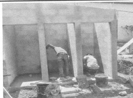
Foto 8: Sustrucción de paredes dañadas del módulo 4.
