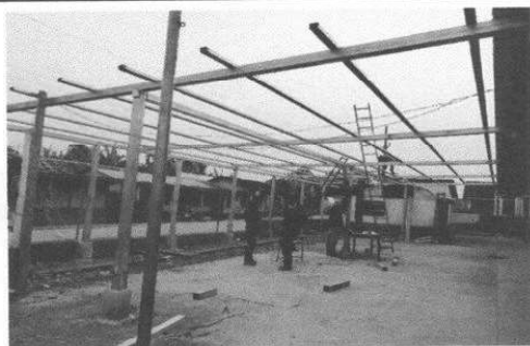
Foto 3: Colocación de estructura metálica del módulo 2.
