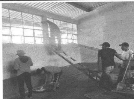
Foto 2: Aplicación de pintura a paredes interiores del módulo 1
