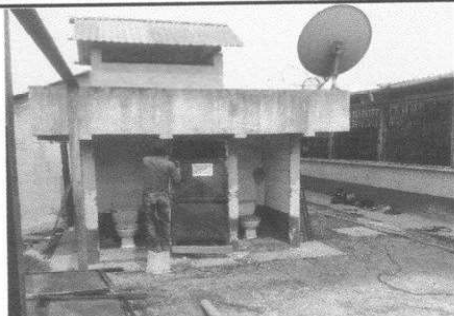
Foto 7: Sustrucción de puertas del módulo 4
