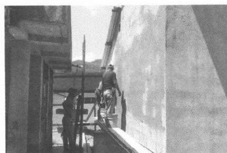
Foto 6: Reparación y repello de pared del módulo 3
