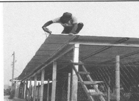
Foto 4: Colocación de lámina del módulo 2.
